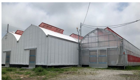
図1 次世代型ハウス外観
